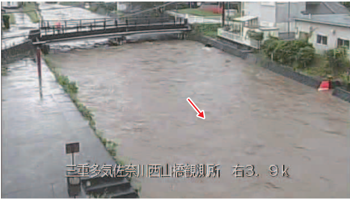
榊田川水系佐奈川右岸3.9k 三重県多気郡多気町 西山橋観測所
