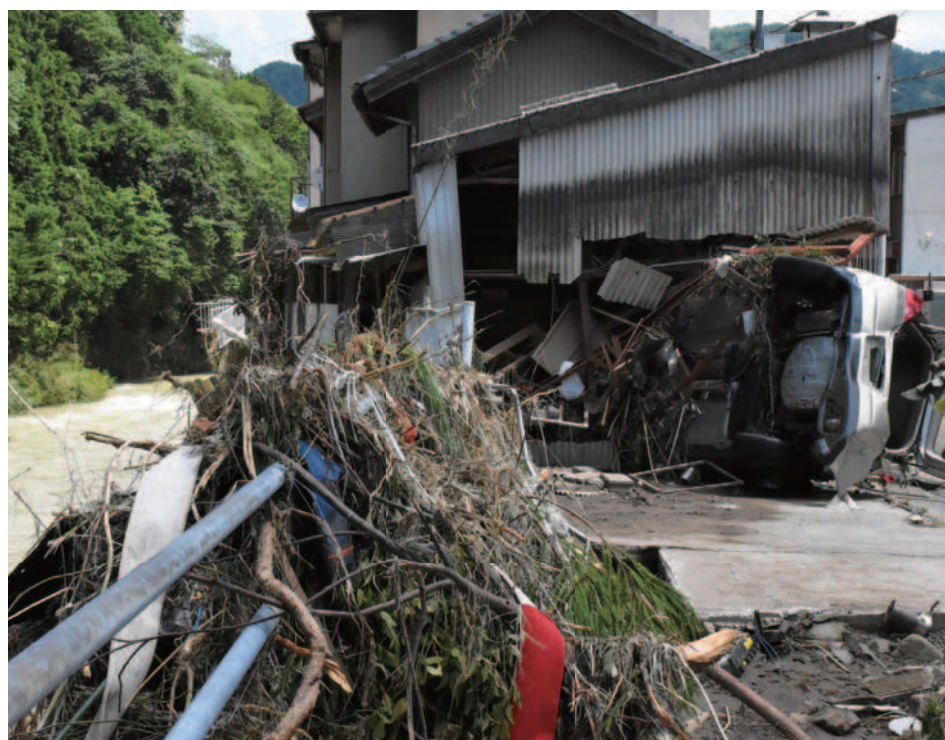
長良川支川津保川の被災状況(岐阜県関市上之保地区)
