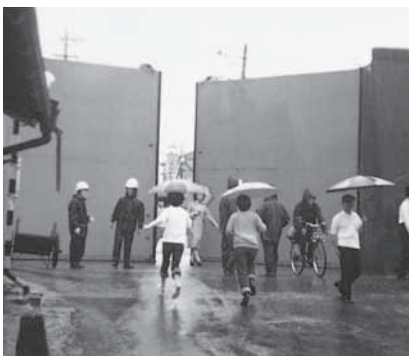
全閉直前の長良陸閘(岐阜市)
