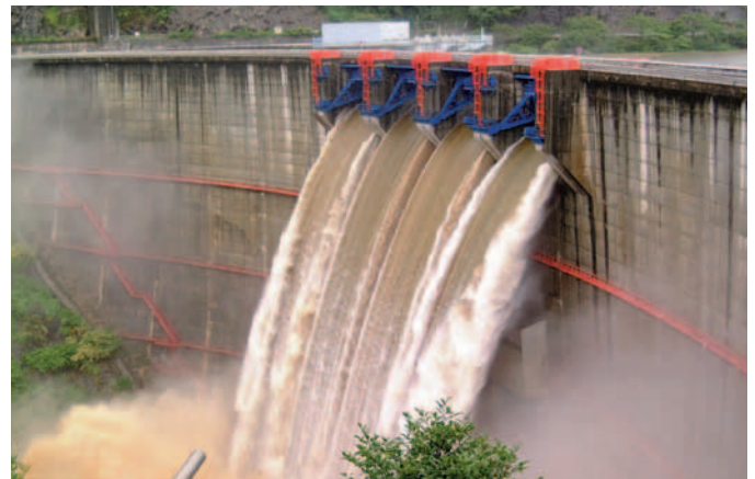
ダムの能力を超える出水により、非常用ゲートで放流
