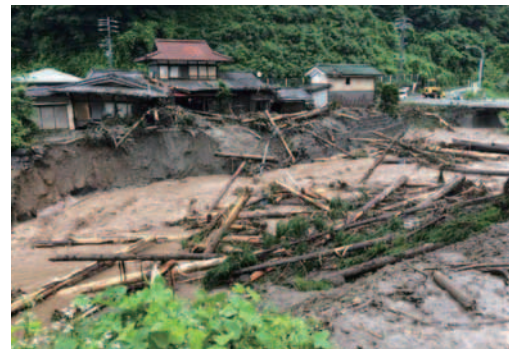
高山市岩井町の土石流被害(高山市岩井町眠木) 提供: 岐阜県
