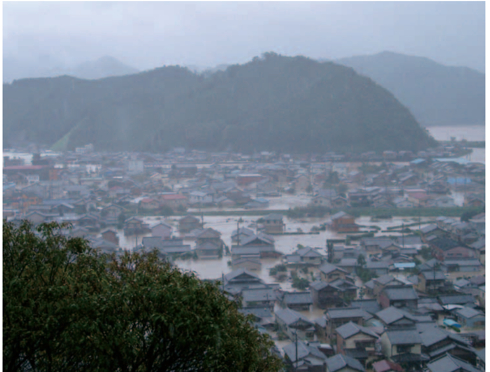
船津川(三重県紀北町)
