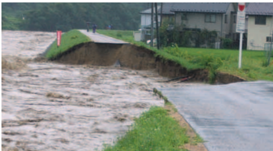
長野県箕輪町松島地区での堤防決壊
