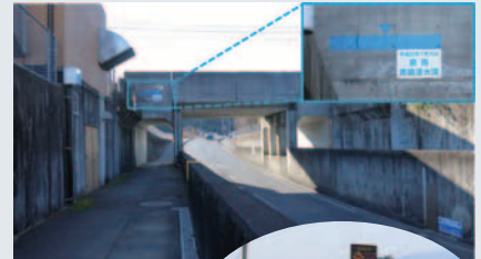
市道50号アンダーパスに残る実績浸水深
