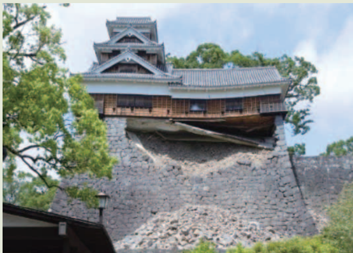
熊本城の被害状況 (熊本県熊本市)
