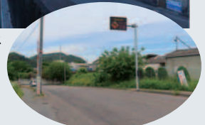
アンダーパス入り口の遮断機・冠水表示板・看板
