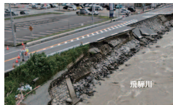
国道41号(岐阜県下呂市萩原)被災状況 出典:国土交通省 中部地方整備局 高山国道事務所
