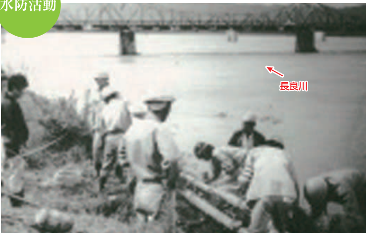
長良川左岸・南濃大橋上流での水防活動(羽島市桑原町)
