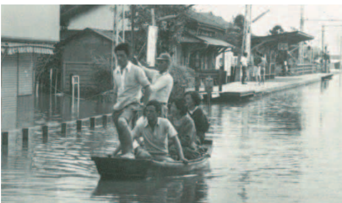
舟による救助活動、冠水した名鉄津島線勝幡駅
