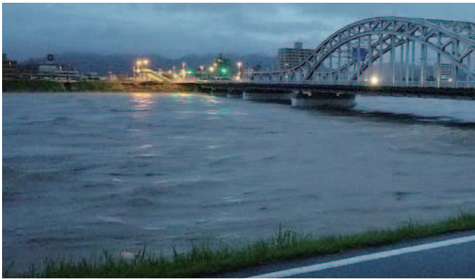
長良川の出水状況（忠節橋下流）
