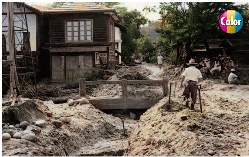
川路地区の被災状況(飯田市)
