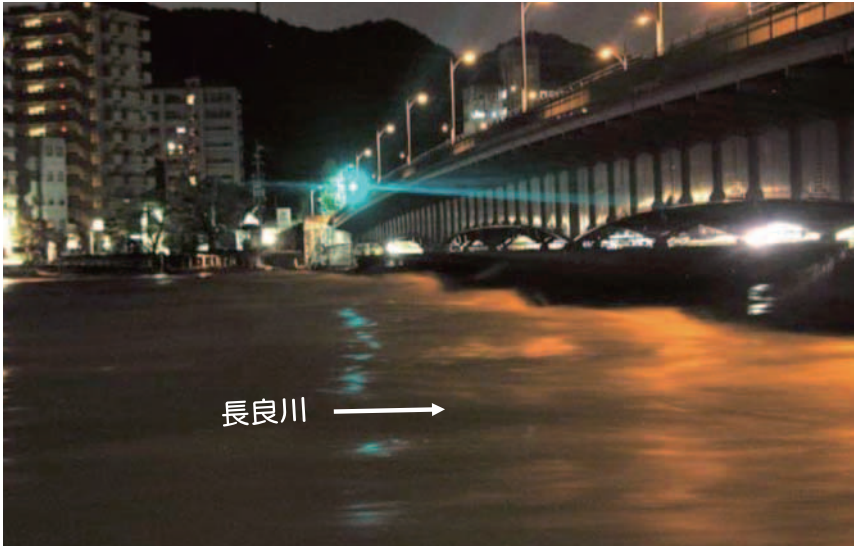
長良橋の出水状況
