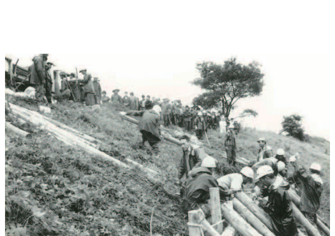
境川堤防での水防活動(羽島市小熊町)
