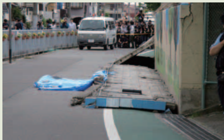
小学校のブロック塀倒壊
