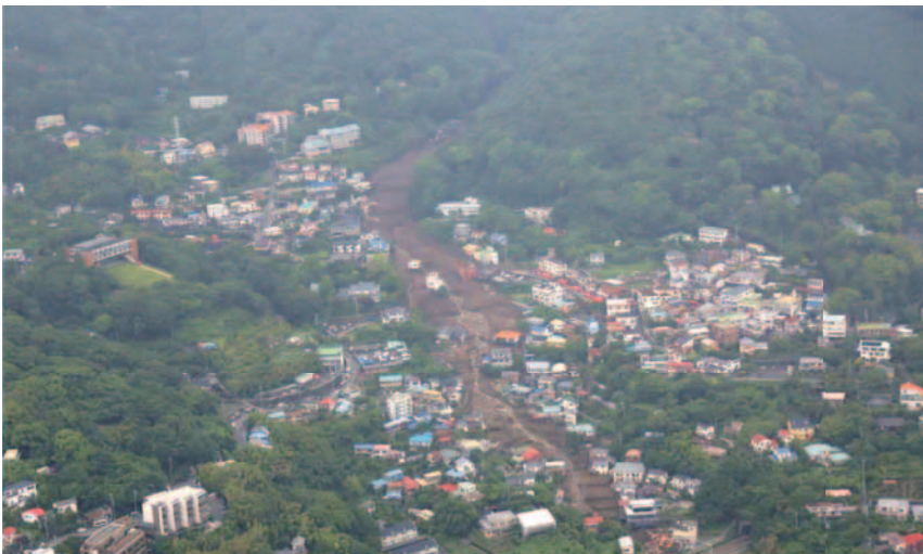
被害状況(熱海市伊豆山地区)
