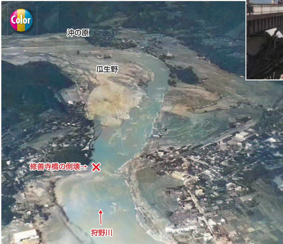
修善寺橋が倒壊し、下流域の地区に大きな被害を及ぼした(静岡県田方郡修善寺町)
