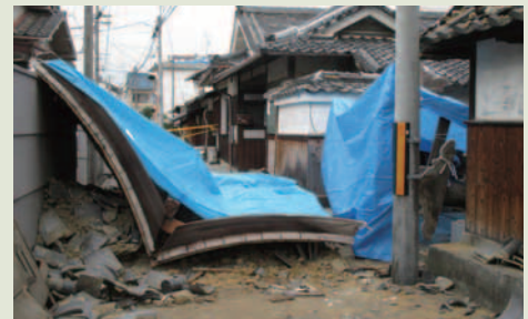
寺院の屋根崩壊
