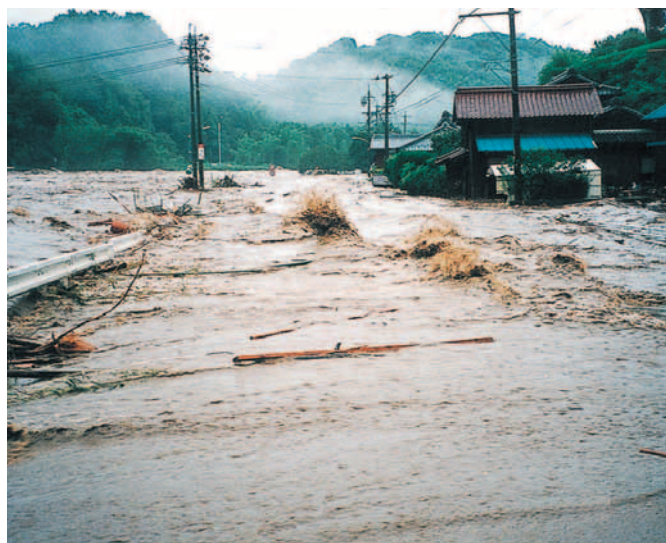
河川の氾らんにより浸水した主要地方道豊田明智線小原地内(豊田市)
