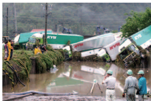
アンダーバスにおける当時の車両被害状況(可児市土田)
