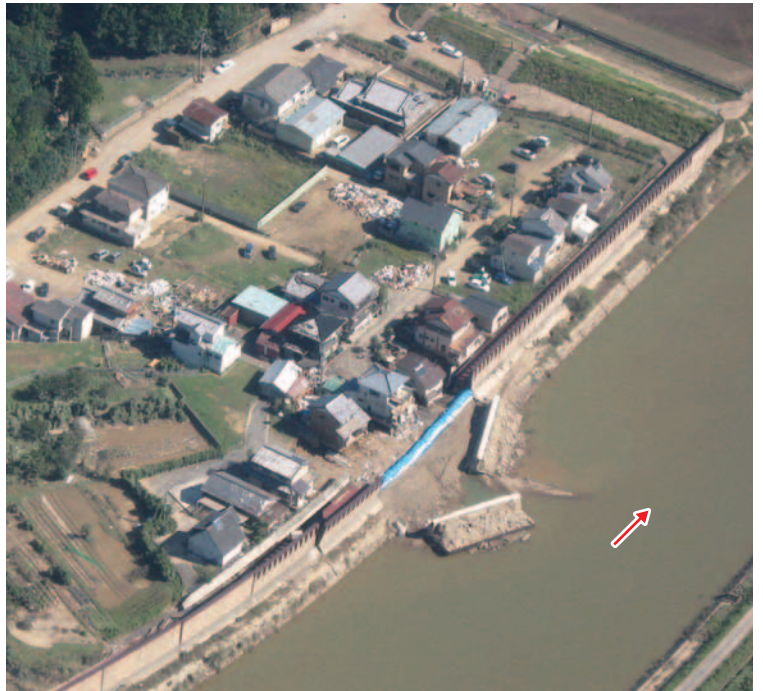
計画高水位を上回った熊野川の支川・相野谷川の輪中堤被災状況
