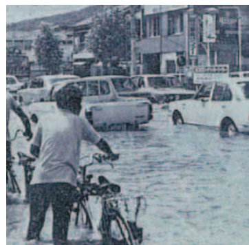
軌道が冠水し運行不能となった当時の名鉄美濃町線(岐阜市) 提供:岐阜県
