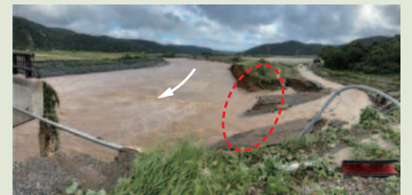
町野川の堤防決壊(石川県輪島市)
