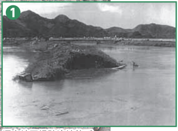
塚本地区堤防決壊箇所 出典：狩野川資料館所蔵写真
