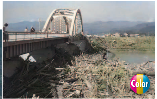
千歳橋に堆積した流木(静岡県田方郡韮山町南条) 白黒写真提供: 国土交通省 中部地方整備局 沼津河川国道事務所
