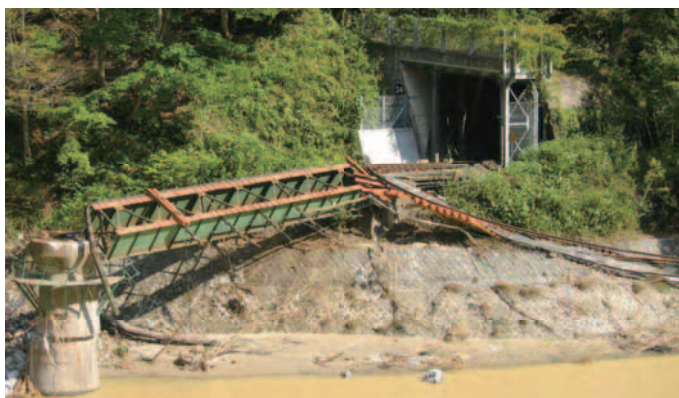
JR高山線鉄橋の決壊(飛騨市宮川町岸奥)
