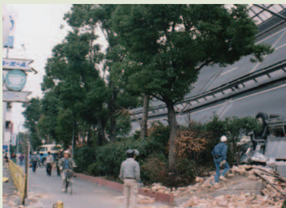
阪神高速道路倒壊(東灘区深江本町) 提供:神戸市
