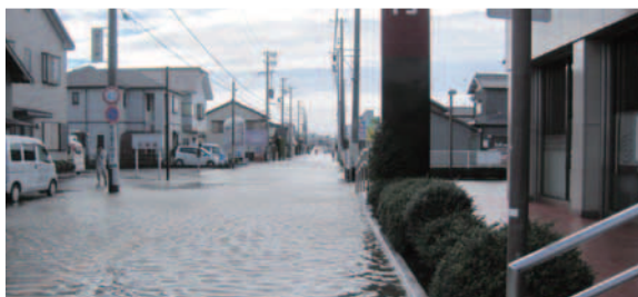
菊川市下平川地区における浸水状況
