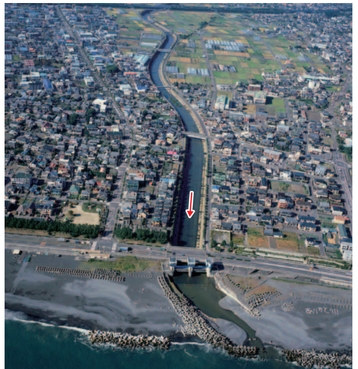
大谷川放水路(静岡市駿河区高松) 提供：静岡県
