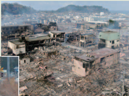
焼失した「輪島朝市通り」周辺 提供：北國新聞社
