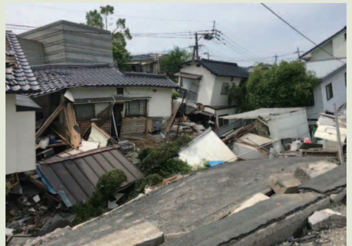
家屋の倒壊状況 (熊本県熊本市)
