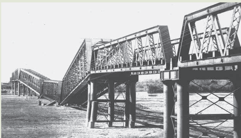
長良川(岐阜一穂積)鉄橋崩落
