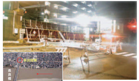
長良陸閘閉鎖状況(長良橋右岸) 長良橋付近(H16.10.21)
