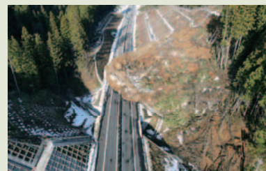
国道470号 能越自動車道の土砂崩れ 出典：国土交通省
