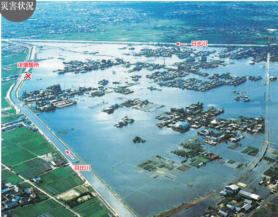
日光川・目比川(愛西市)合流地点付近の堤防決壊による浸水状況
