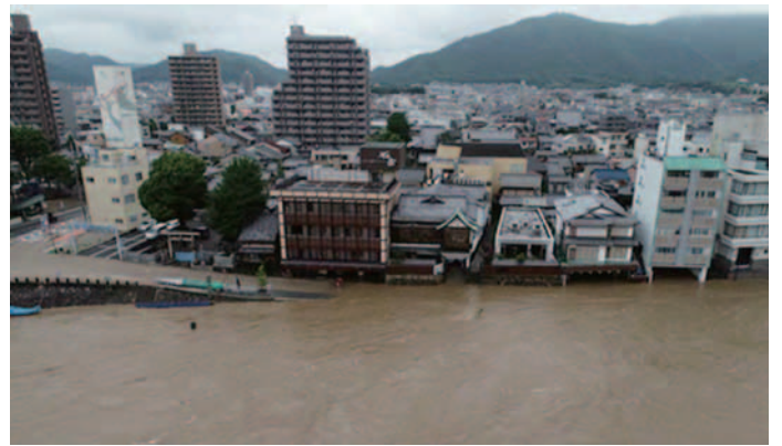
長良川の出水状況（長良橋上流）
