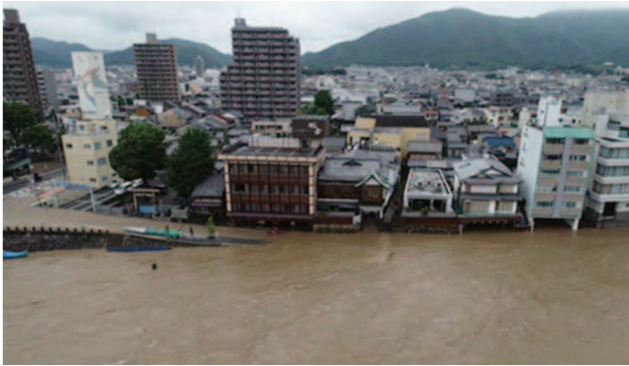
長良川の出水状況（長良橋上流）
