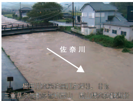
櫛田川水系佐奈川3.9k右岸(西山橋水位観測所)の出水状況 出典：国土交通省 中部地方整備局 河川部
