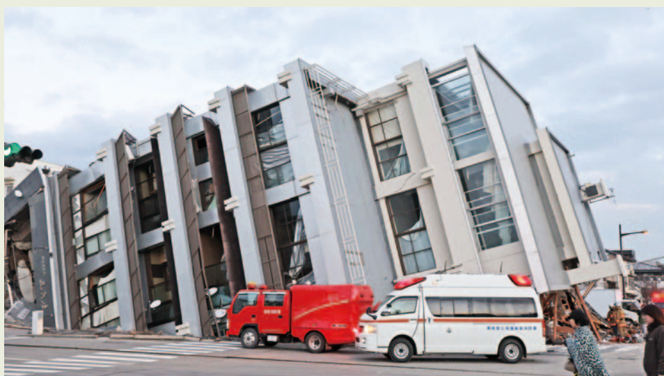
倒壊したビル(輪島市)
