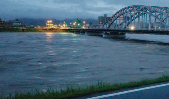
長良川の出水状況（忠節橋下流）
