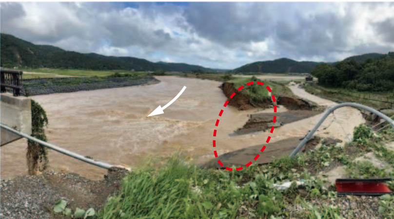
町野川の堤防決壊(石川県輪島市) 出典:国土交通省 北陸地方整備局
