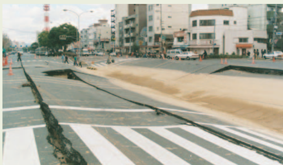
道路の陥没(兵庫区大開通)
