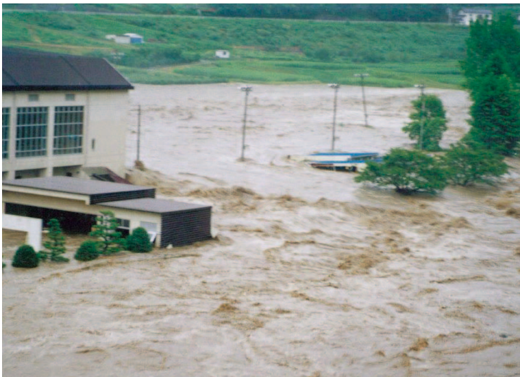
河川の氾濫により流出した幼稚園と浸水した小学校体育館(矢作川71km地点小渡地区)
