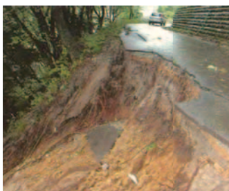
大きく削り取られた松坂線の道路 (飛騨市神岡町釜崎)
