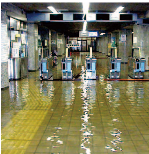
浸水した地下鉄平安通駅コンコース
