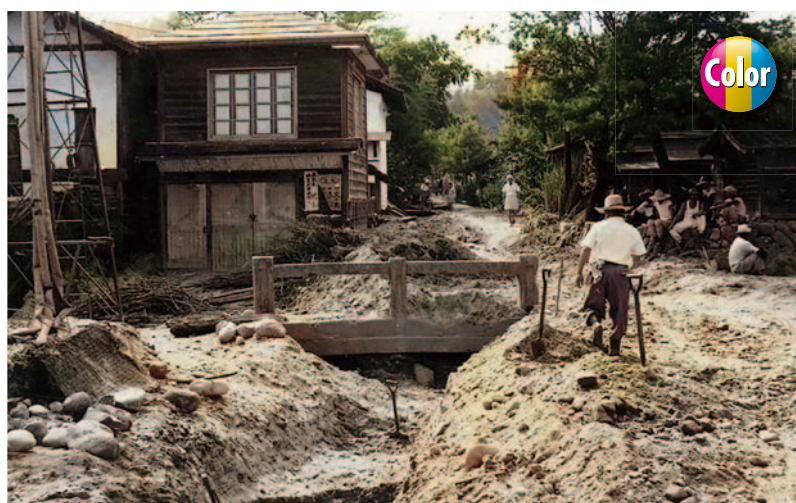
川路地区の被災状況(飯田市)
