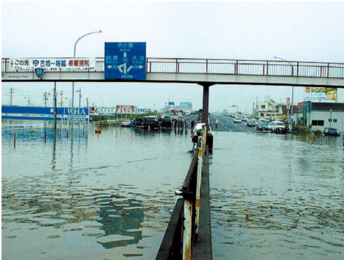
冠水した国道22号(西枇杷島町)
