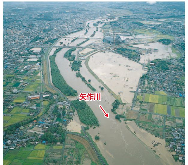
豊田大橋付近の出水状況(矢作川39km付近)
