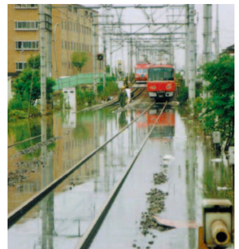
名鉄名古屋本線鳴海駅付近の浸水状況
