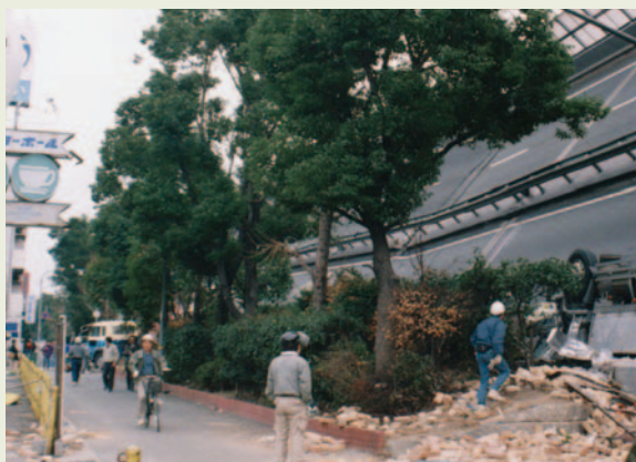
阪神高速道路倒壊(東灘区深江本町)
