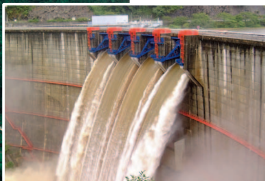
ダムの能力を超える出水により非常用ゲートで放流
