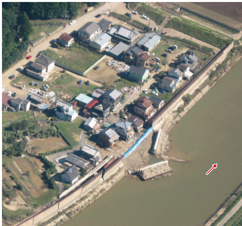
計画高水位を上回った熊野川の支川・相野谷川の輪中堤被災状況
