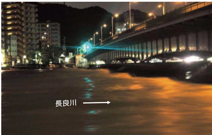
長良橋の出水状況
