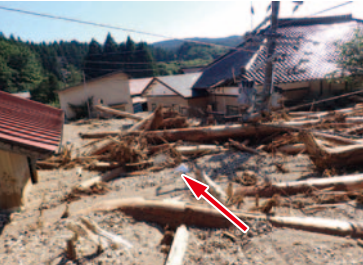
土砂災害発生状況(山形県酒田市北青沢) 出典：国土交通省
