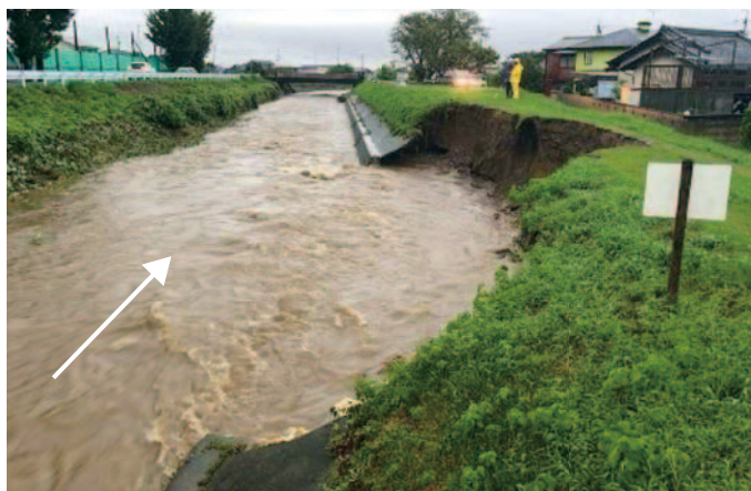
三渡川水系堀坂川(松阪市田牧町)の堤防洗掘 出典：国土交通省 中部地方整備局 河川部
