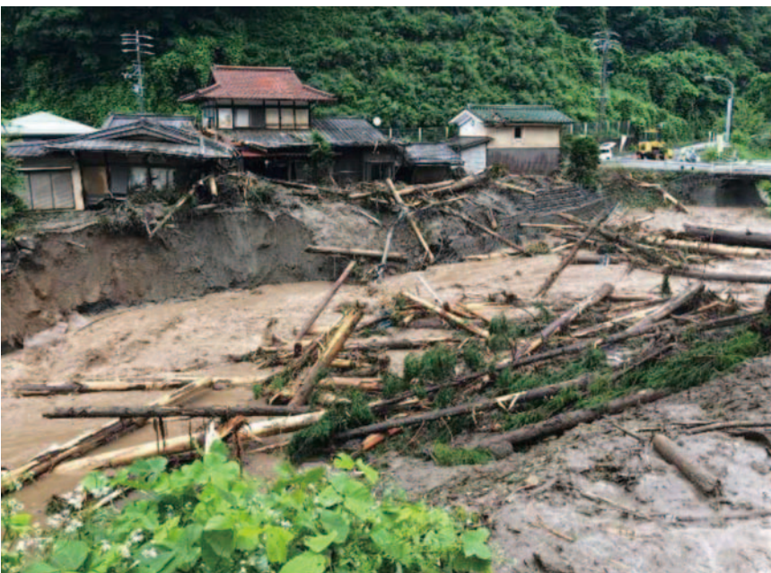
高山市岩井町の土石流被害(高山市岩井町眠木)
