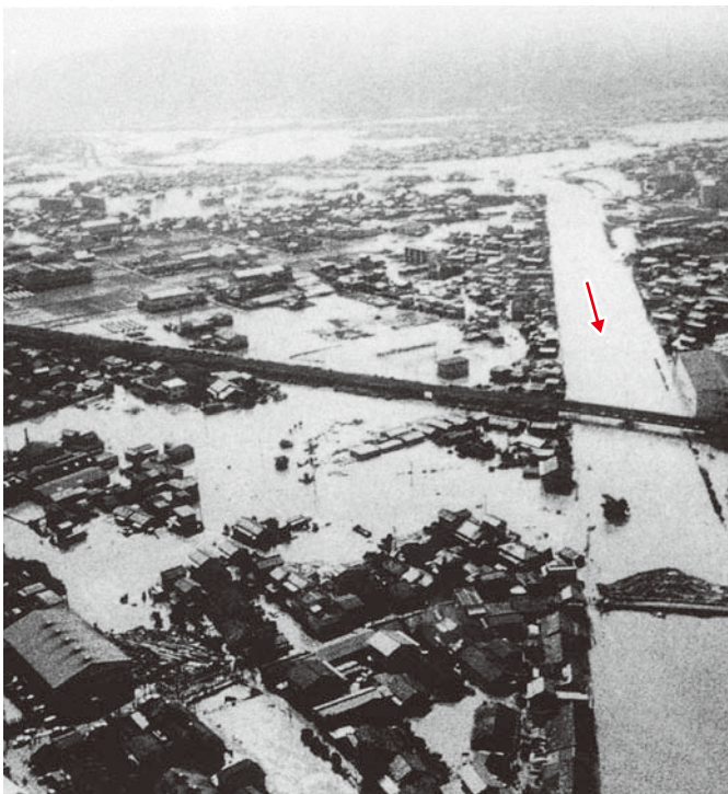
巴川の決壊による静岡県清水市内の浸水状況
