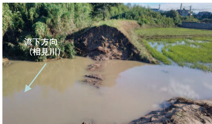
堤防が決壊した広田川
