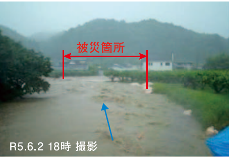
敷地川（静岡県磐田市敷地地内）の堤防決壊 出典：国土交通省 中部地方整備局 河川部
