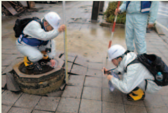
浮き上がったマンホール（石川県輪島市） 国土交通省TEC-FORCE撮影
