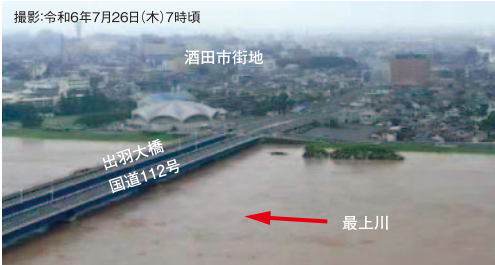
最上川下流左岸3.0km付近の出水状況(山形県酒田市) 出典：国土交通省 東北地方整備局 河川部
