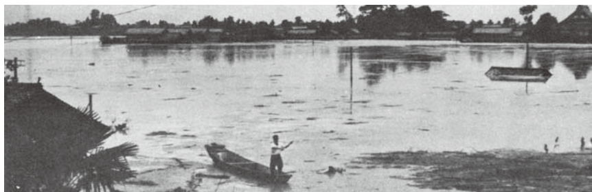
昭和34年台風7号 牧田川の堤防決壊により軒下まで浸水した根古地地区(岐阜県養老郡養老町)
