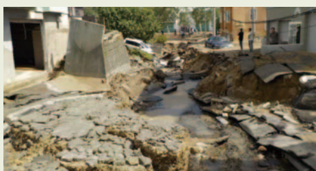
札幌市の液状化による被害
