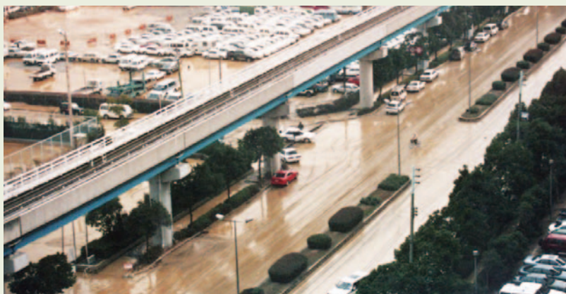
液状化の様子(中央区港島中町)
