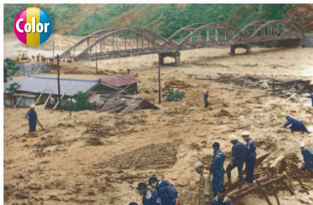
小渋橋下流で多量の土砂により 家屋が埋没(大鹿村)
