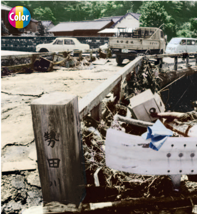
勢田川姫之橋付近の被害状況(三重県伊勢市岡本)
