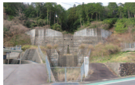
完成した砂防堰堤（八百津町野上地区） 撮影：令和7年4月
