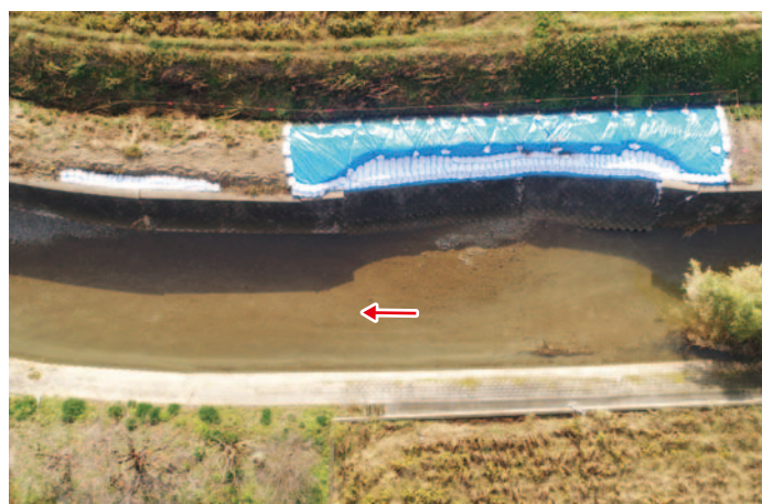
櫛田川水系佐奈川右岸5.0k付近 護岸欠損応急対策状況(多気郡多気町五柱)
