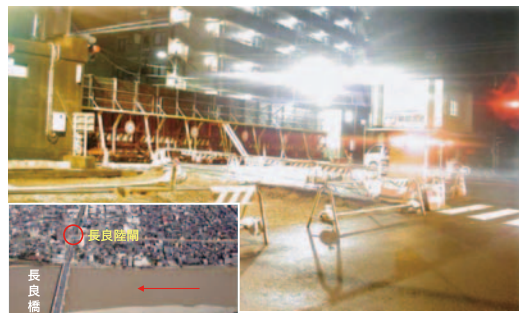
長良陸閘閉鎖状況(長良橋右岸) 提供：国土交通省 中部地方整備局 長良橋付近(H16.10.21)
