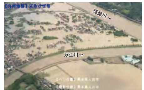
熊本県人吉市の浸水状況 出典: 国土交通省 九州地方整備局
