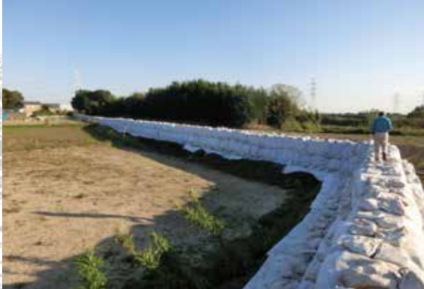
大型土嚢による仮堤状況
