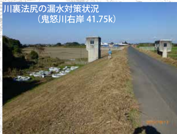
川裏月輪工法の設置状況 (下流側から撮影)
